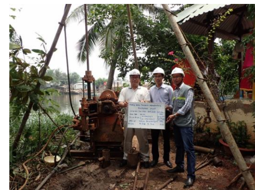
<堤防の土質調査>
