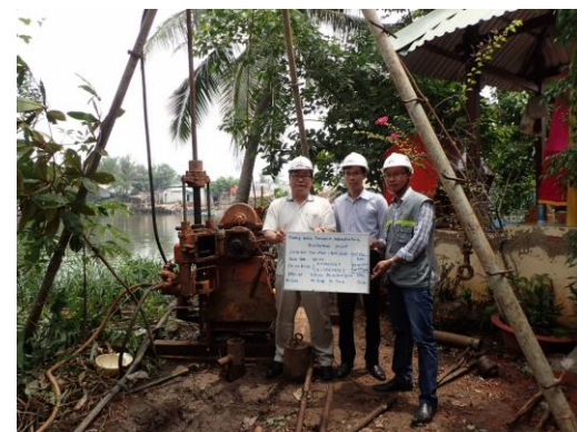
＜堤防の土質調査＞
