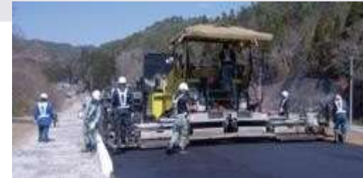
再生アスファルトを活用した舗装
