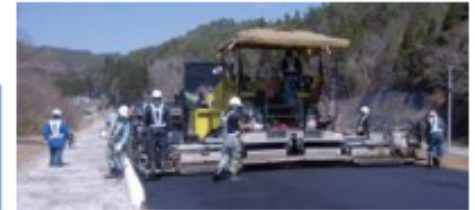
再生アスファルトを活用した舗装
