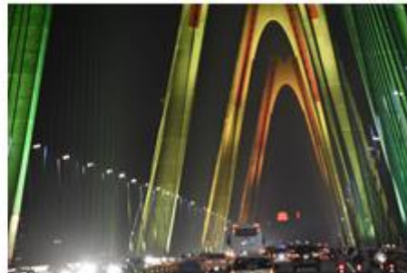
< ニャットン橋 >
