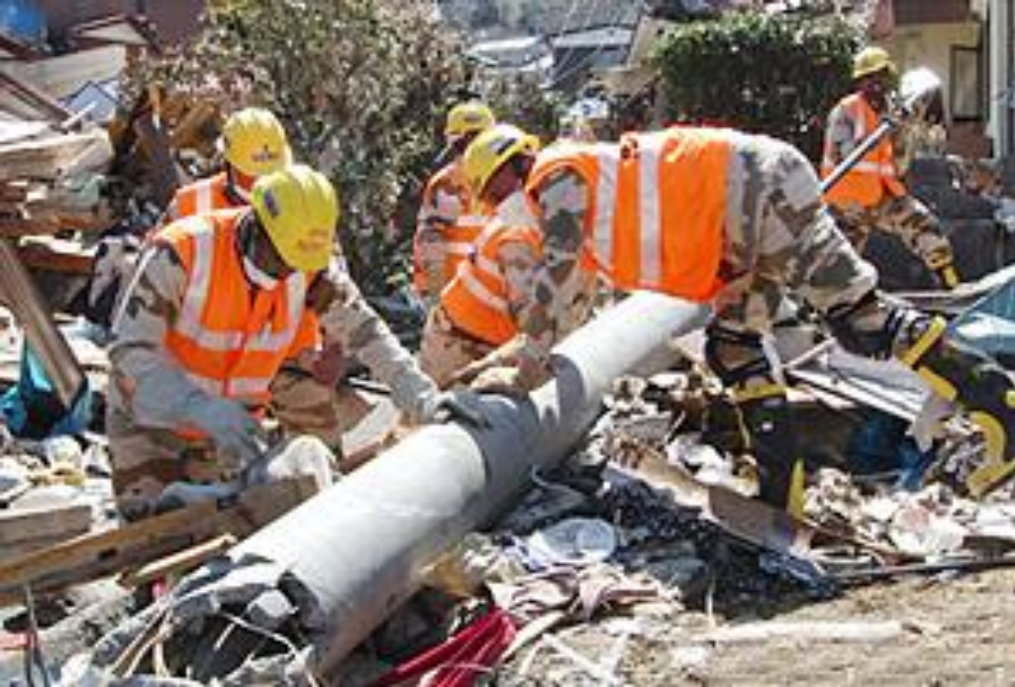
電信柱撤去作業を行う インド隊員
