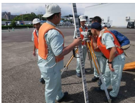
陸上での測量作業の様子(水準測量)
