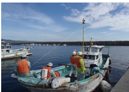
海上での測量作業の様子(作業船)
