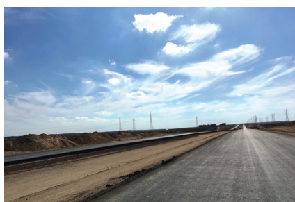
Partie enrobée d'une section de l'autoroute
