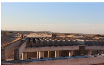
Travaux de construction en cours
