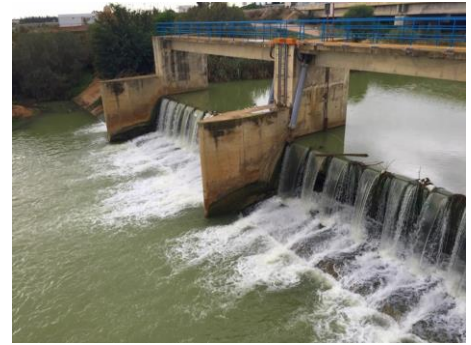
Barrage Tobias situé en aval de l'Oued Mejerda
