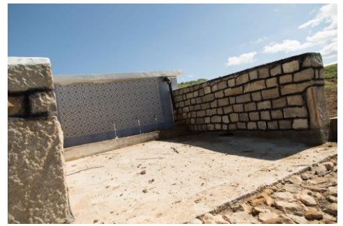
Construction de citernes
