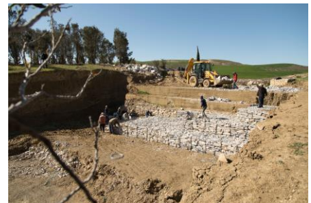
Travaux de conservation d'eaux et de sol
