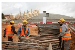
Construction de réservoirs dans les cités de Oued Ellil et Ettadhamen
