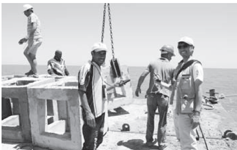
「ガベス湾沿岸水産資源共同管理プロジェクト」にて実施された人工魚礁の設置作業
