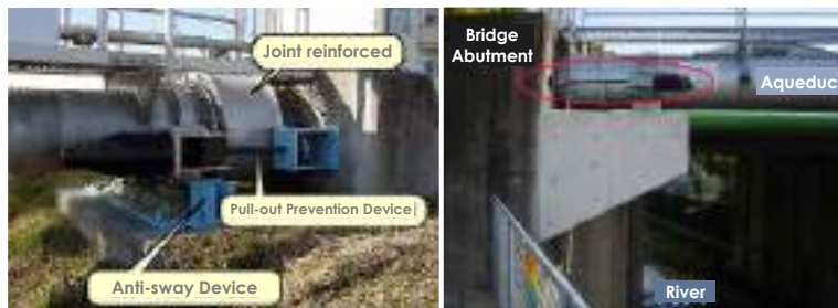
Şekil 5-6 Su Kemerlerinde Sismik Güçlendirme ve Çökmenin Önlenmesi (Konsept ve Örnek)
