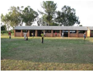
ドナーの支援で建設された小学校の例
