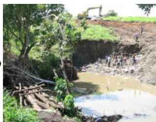
橋梁1工事現場 左側が以前の橋。右奥が新橋梁の基礎。
