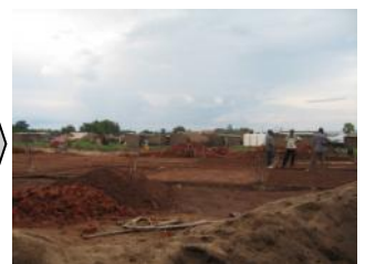
現在の様子 公共サービスホールの基礎部分
