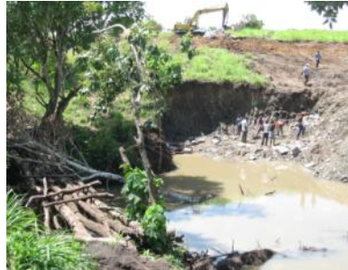
「橋梁1」工事現場 (2010年5月)
