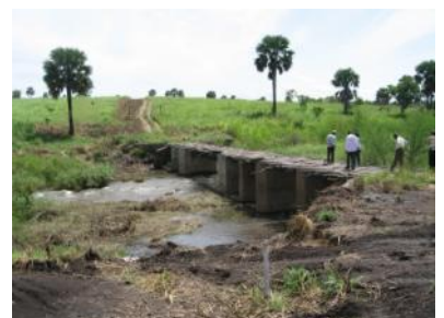
「橋梁2」工事現場 (2010年6月) 周囲が切り開かれた
