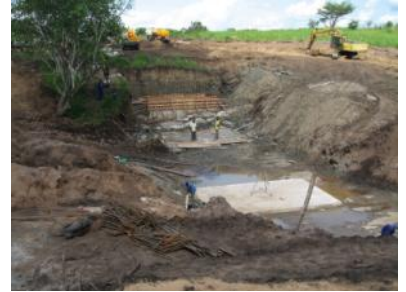
「橋梁1」工事現場 (2010年6月) 橋脚基礎部分の掘削が終了した。
