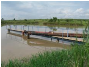
①貯水池 オイティノ・ダム
