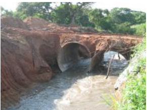
迂回水路の様子。パイプカルバート2本に土嚢を積み、車両通行可能な仮橋を設置していた(左)が現在は人、自転車、バイクのみ通行可能(右)。
