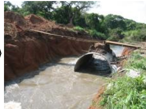
迂回水路の様子。パイプカルバート2本に土嚢を積み、車両通行可能な仮橋を設置していた(左)が現在は人、自転車、バイクのみ通行可能(右)。
