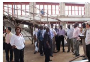
多目的ホール建設現場を視察
