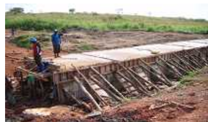
図-2 側壁部を養生中
