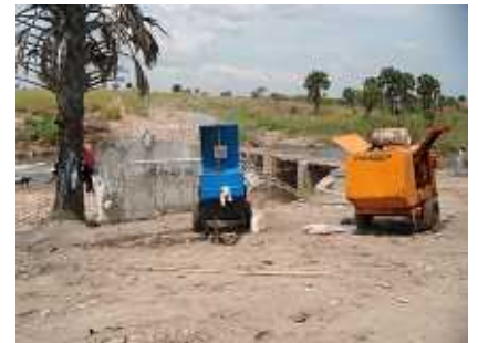
はつり作業のためのコンプレッサー
