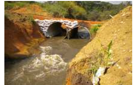
迂回水路の現況(現在)
