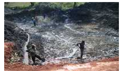
図-3 基礎部分の掘削作業風景
