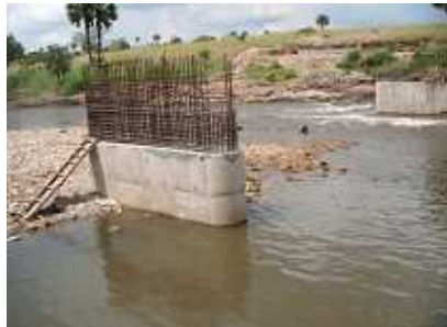
橋脚の追加鉄筋据付け終了
