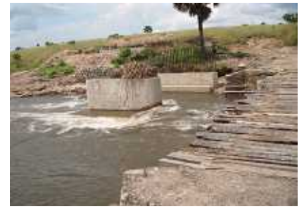
迂回水路確保のため北側の橋脚は施工中止
