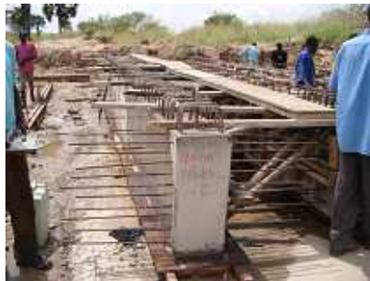
橋桁の製作作業風景
