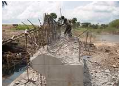
橋台のはつりの様子(南側)
