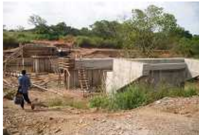
LOT1 橋梁工事現場の様子
