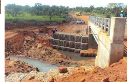
右上 Dawa橋付近 道路改良工事 土のラテライト色が印象的です
