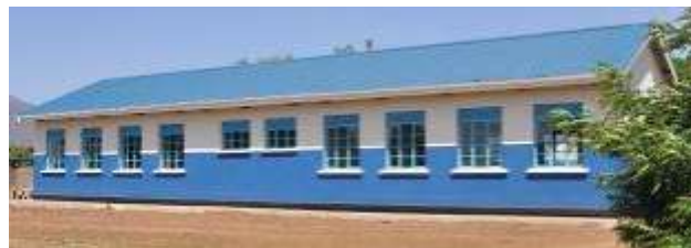
左写真はKokil小学校に新設された教室棟。
