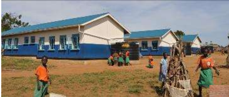
Pader県Papaa小学校。後ろに見える3棟が新設教室棟。この学校では今年になって植樹や校内敷地の整備などが急速に進んでおり、プロジェクトとの相乗効果が見られます。
