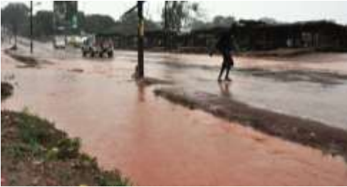
短時間に強い雨が降ると側溝が溢れ冠水するこの区間は、工事の大きなポイントの一つ。
