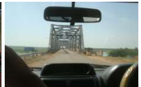
西ナイルとアチョリを結ぶPakwach橋
