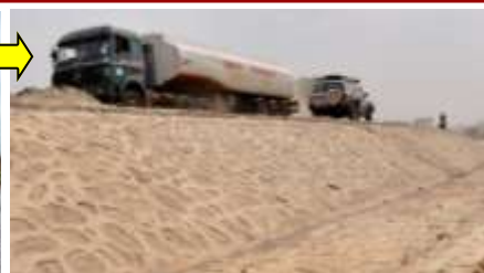
雨期には冠水していた道路は2m近くかさ上げされ、排水のため広い水路が作られた。また同じく水浸しになっていた道路脇の商店の環境も大きく改善された。
