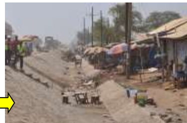
雨期には冠水していた道路は2m近くかさ上げされ、排水のため広い水路が作られた。また同じく水浸しになっていた道路脇の商店の環境も大きく改善された。
