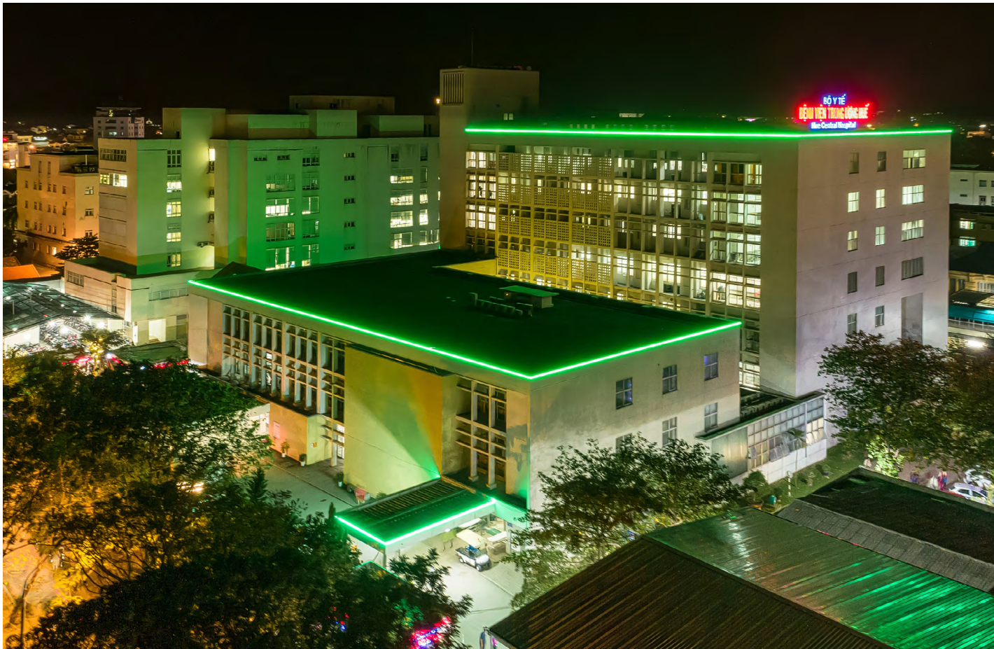
Trung tâm kỹ thuật cao Bệnh viện Trung ương Huế được xây dựng bằng nguồn viện trợ không hoàn lại (ODA) của Nhật Bản
