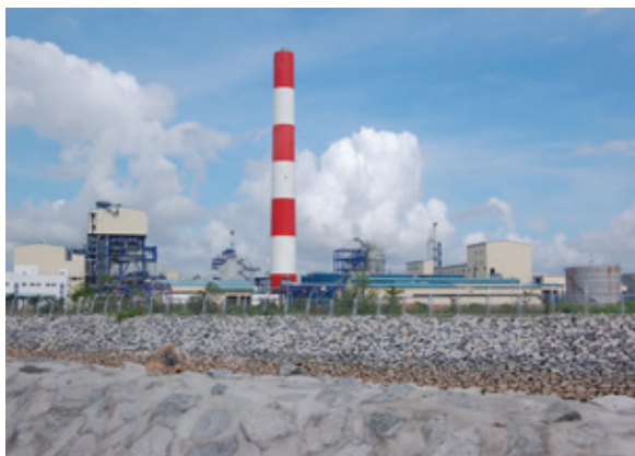
Nhà máy nhiệt điện Ô Môn
