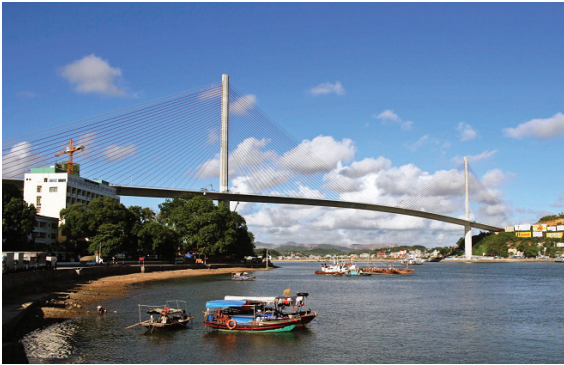
Cầu Bãi Cháy
