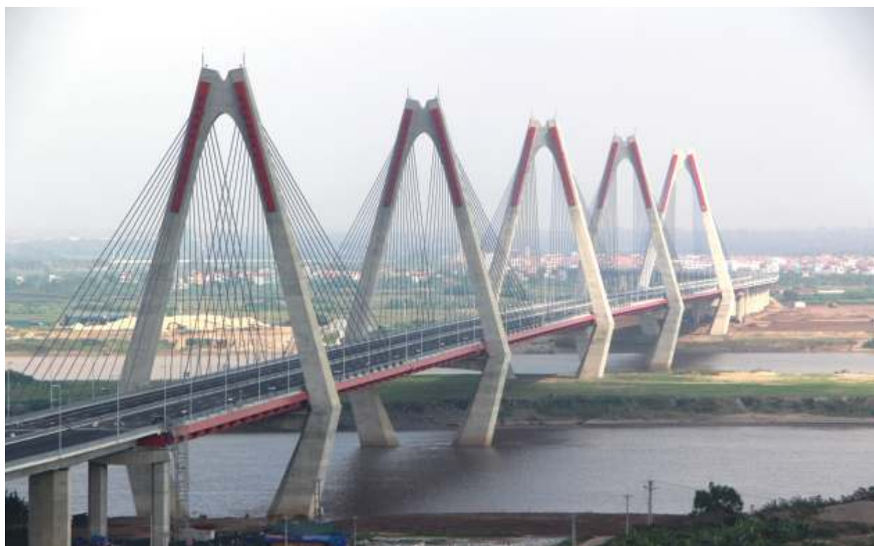
▲全長3755mのニャットン橋。主橋長は1500m。同じ斜張橋の横浜ベイブリッジ（橋長860m）の約2倍の長さ
