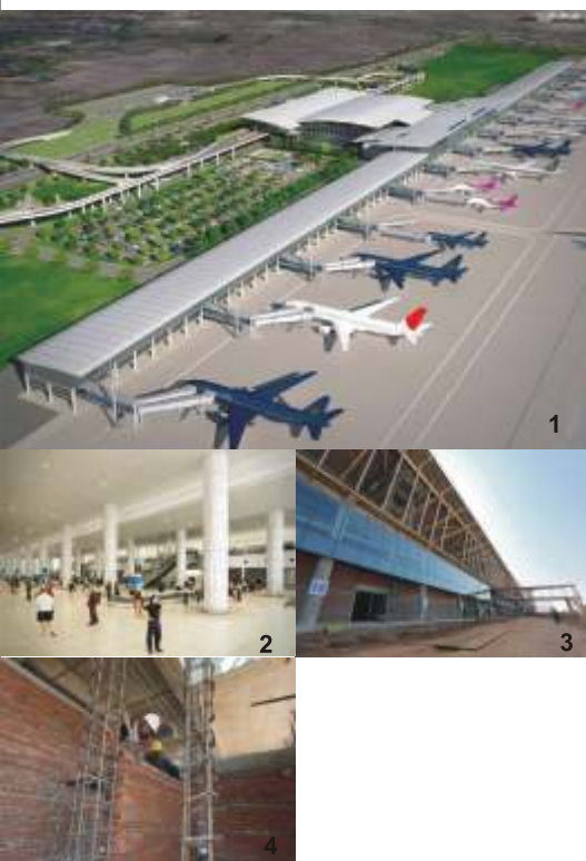
1 総床面積約15万2000㎡、96のチェックインカウンターを備える 2 ターンテーブルの数も従来と比べ増加している 3 空港の壁面にはベトナム産のレンガが使われている 4 搭乗橋は計28本。同時時間帯の離着陸にも十分な処理能力を持つ
