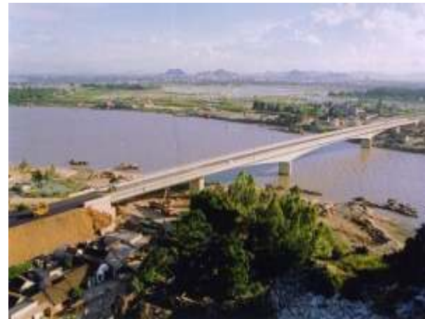
国道1号線のホアアン・ロン橋
