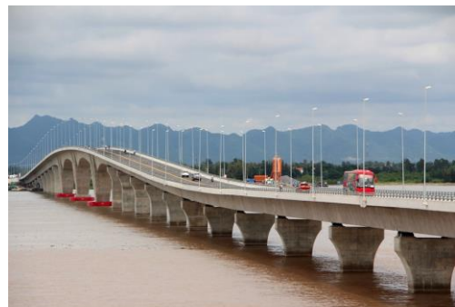
ディンブー・カットハイ橋（写真：三井住友建設）
