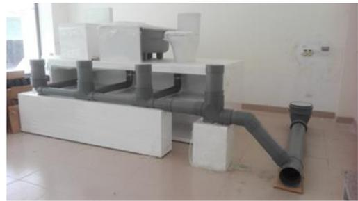
カウンターパート機関に設置した排水設備のモデル
