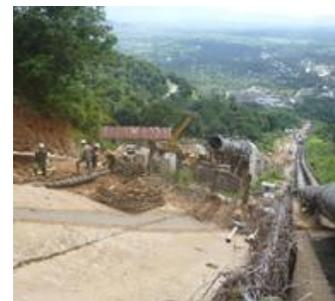
国道を横切る箇所での新設鉄管の設置（中央右側）とその手前の防護柵
