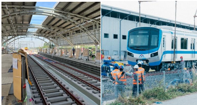
工事が進むホーチミン市都市鉄道1号線。車両も順次到着（写真提供：MAUR）
