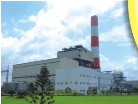
Nhà máy nhiệt điện Ô Môn
