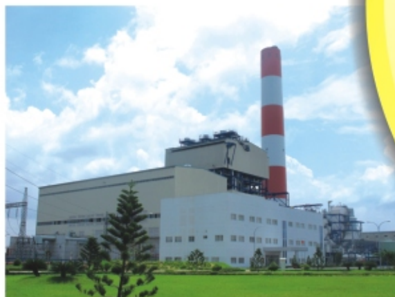
オモン火力発電所
