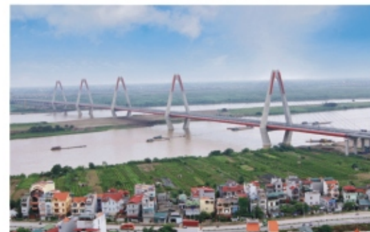
ニヤタン橋(日越友好橋)
