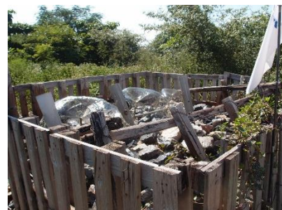
現地で調達可能且つ安価な資材を用いた廃棄物処分場(ハイフォン市の廃棄物埋立管理技術の能力向上支援)
