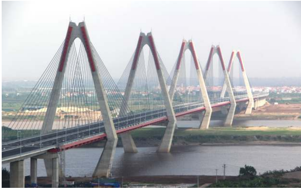
▲ Toàn thể cầu dài 3.755m. Trong đó phần cầu dây văng dài 1.500m, dài gần gấp đôi cây cầu dây văng nổi tiếng Bay Bridge ở Yokohama (860m)
