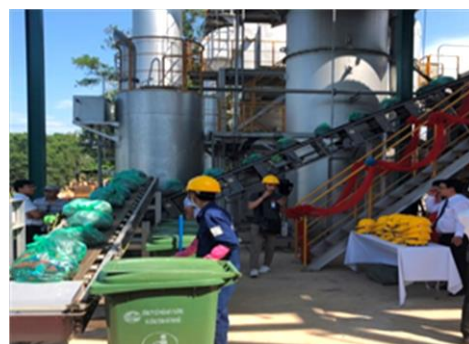
Lò đốt chất thải của Công ty Actree tại Thành phố Huế
