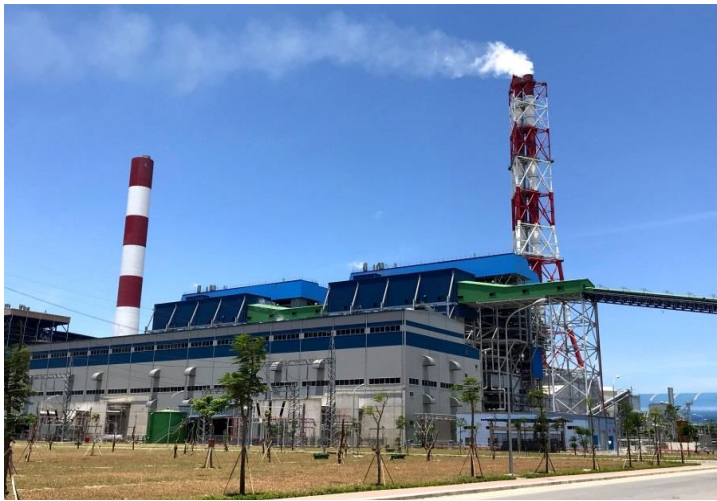
Nhà máy nhiệt điện Thái Bình
