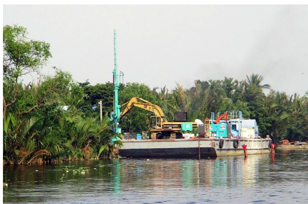
Vận chuyển máy móc lên tàu tiếp cận bờ kè bằng đường sông
