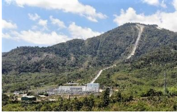
Toàn cảnh nhà máy thủy điện Đa Nhim và đường ống áp lực
