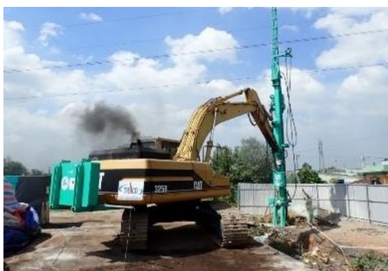
Với lợi thế thiết bị nhỏ và nhẹ hơn thiết bị thông thường, hệ thống CMS có thể được sử dụng linh hoạt ngay cả ở những khu vực đông dân cư và diện tích thi công nhỏ hẹp, yếu
