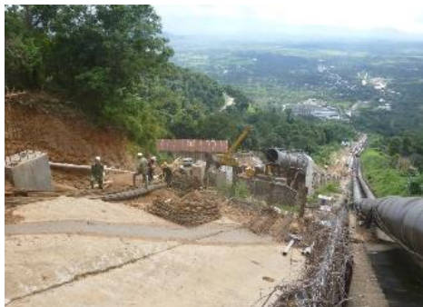
Lắp đặt đường ống mới tại khu vực bắt ngang qua quốc lộ (giữa ảnh) và hàng rào bảo vệ phía trước
