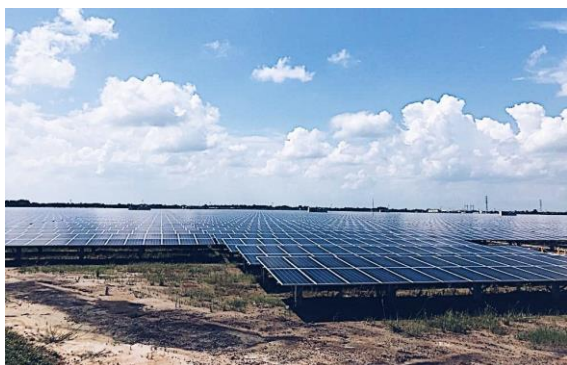
Toàn cảnh nhà máy điện mặt trời
