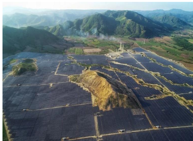
Toàn cảnh khu vực nhà máy điện tại tỉnh Phú Yên
