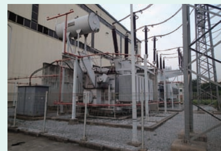
Trạm biến áp
