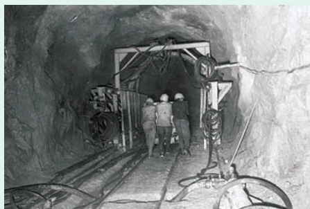
Quang cảnh khoan đường hầm áp lực
