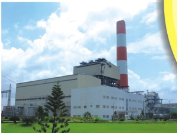
Nhà máy nhiệt điện Ô Môn
