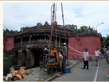
Khoan địa chất đánh giá cấu trúc địa tầng
