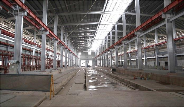
Công trình bãi đỗ tàu đang dần được hoàn thiện.
