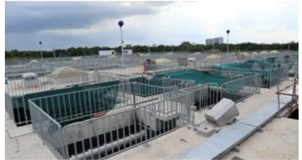
Nhà máy xử lý nước thải Bình Hưng
