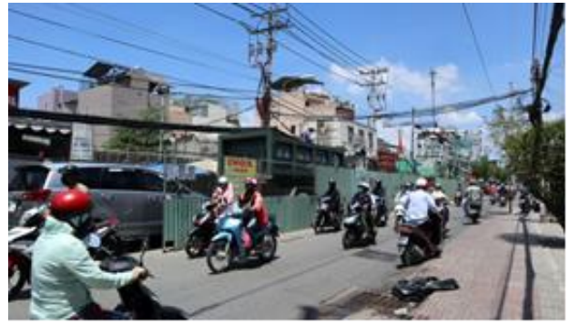
Công trường dự án
