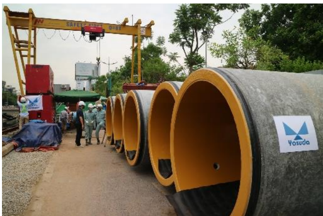
Đốt cống ngầm có đường kính 1,5m được gia công đặc biệt chống ăn mòn
