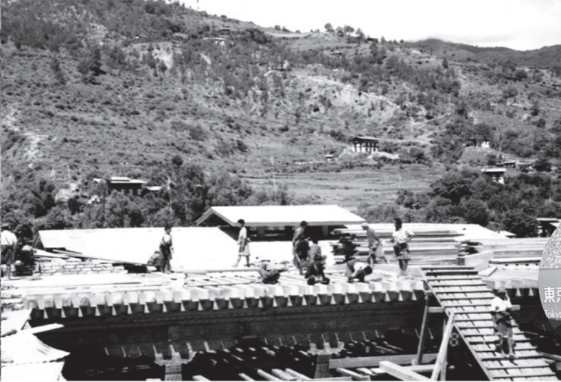
平山さんが携わった、プナカ・ゾンの改修工事の様子
