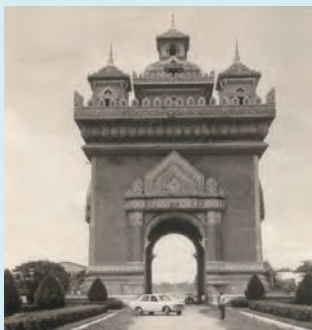
ビエンチャンにそびえ立つ「アヌサーワリー・パトゥーサイ」は、内戦による戦没者の慰霊碑として1960年代から建設が始まった建物で、パリの凱旋門を模している。写真は66年に撮影された一枚
